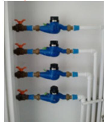
Imagem: Local para instalação dos medidores individuais de água fria
