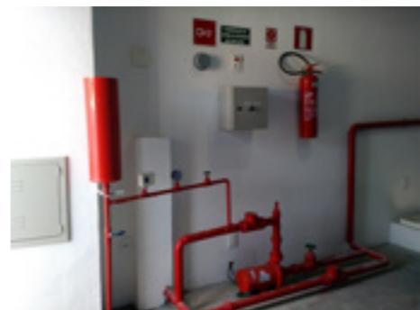
Imagem: Bombas, registros e quadro de comando da bomba de incêndio
