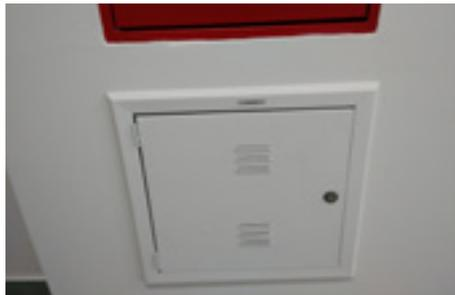
Imagem: Quadro de distribuição para Tv a cabo no hall dos pavimentos
