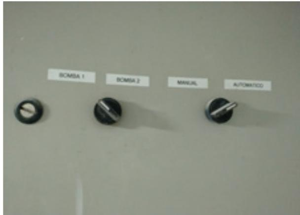
Imagem: Detalhe quadro de bombas de recalque
