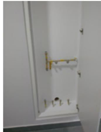
Imagem: Local para instalação dos medidores individuais de gás
